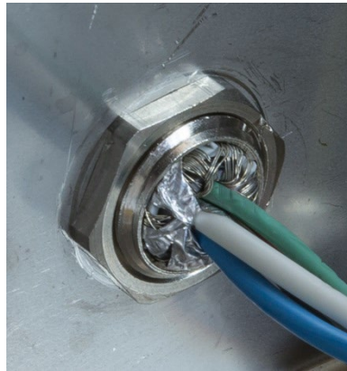
图 A-60：接头螺母已安装
