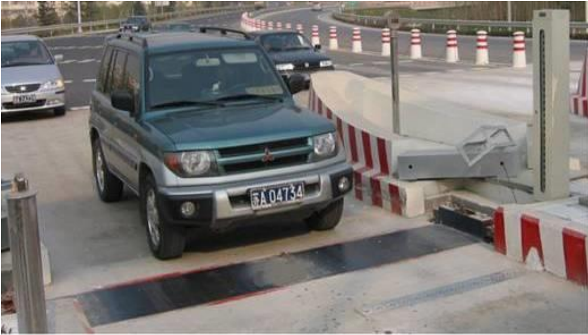
图4 秤台式轴重秤（上翻梁）平面布置
