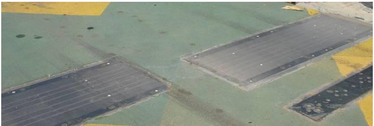
图13 弯板轴重秤（剪切梁式）平面布置
